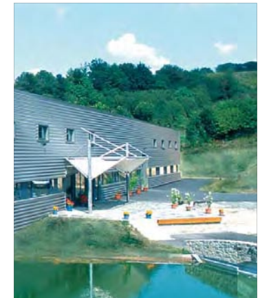
interscience Centre R&D et usine de production
