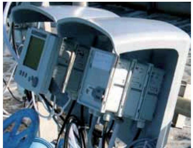
IQ SENSOR NET sous auvent de protection SSH/IQ
