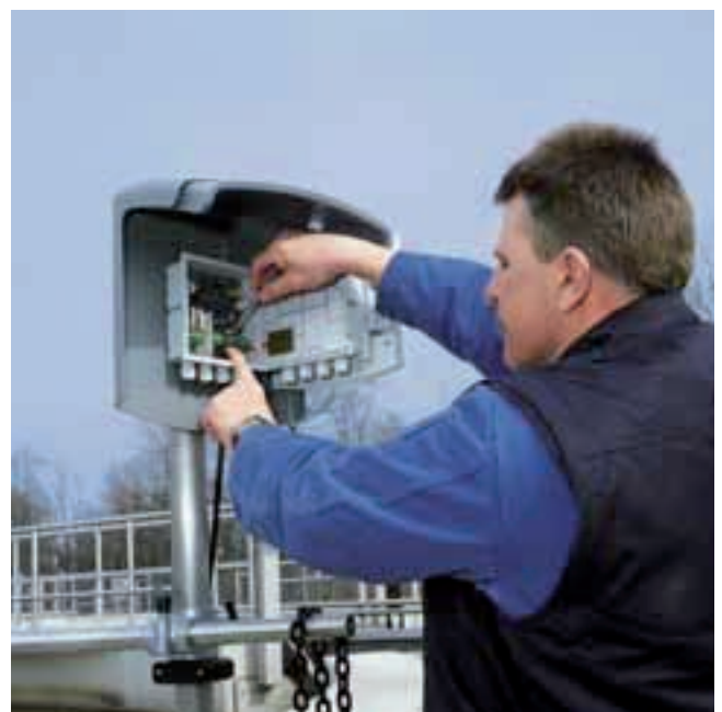
Installation simple au bord du bassin
